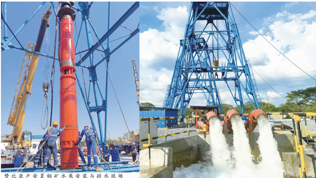
赞比亚卢安夏铜矿水泵安装与排水现场
