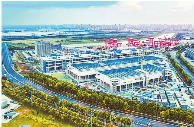
连日来,合肥派河国际综合物流园汽车物流中心项目建设正酣。该项目主要建设高标准多层立体停车库、智能化仓储中心及配套用房,目前2号、3号、4号、5号楼主体已经封顶。(王世保)
