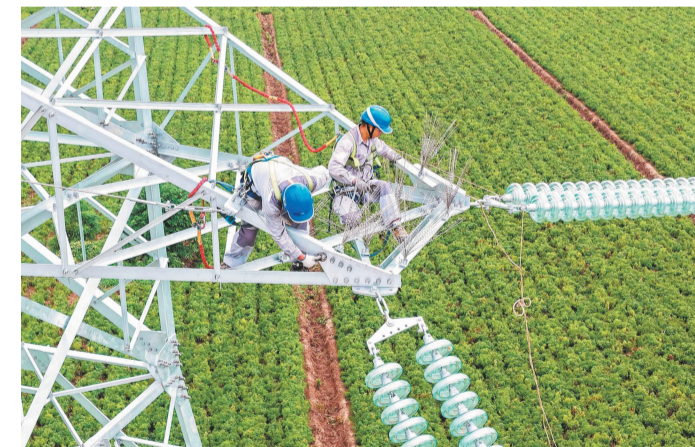
在蒙城县墨泉—蒙城牵引站220千伏线路40号杆塔,国网亳州供电公司工作人员在进行送电前的消缺工作,确保设备以“零缺陷”状态投入运行。该线路预计今年7月8日投运,是阜淮铁路的配套供电设施。
