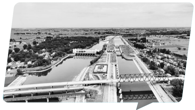
5月12日,位于滁县的沱浚河航道整治二期工程的关键节点——韩村北桥主体已经雄姿初显。该桥建成后,将彻底打通北岸韩村镇与南岸的交通梗阻。(万善朝 王敏)
