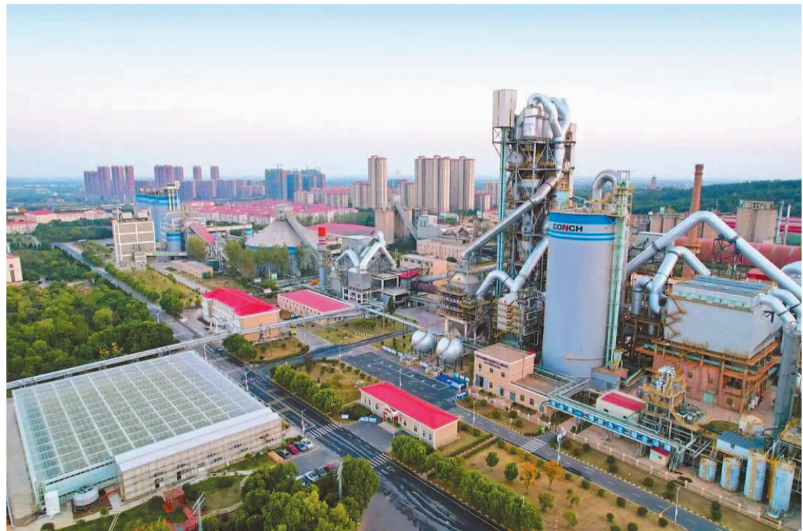
海螺集团芜湖白山水泥厂近日建成的全绿电示范工厂,系行业首个集“光伏发电、电化学储能、智能微电网、新能源汽车充电桩”于一体,成功实现了绿色能源的自发自用、余电存储和智能调控,为传统工业尤其高耗能企业绿色转型蹚出一条新路。(陈昱)
